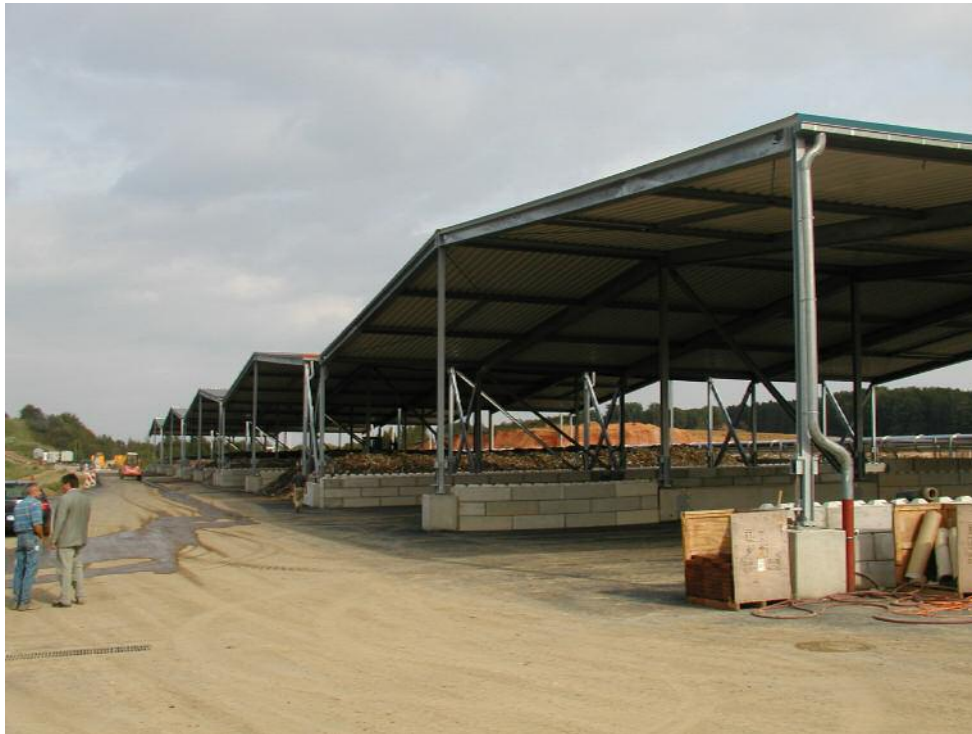
Abbildung 5 Überdachte und saugbelüftete Nachrotte MBA Singhofen Open aerated pile composting plant MBT Singhofen
